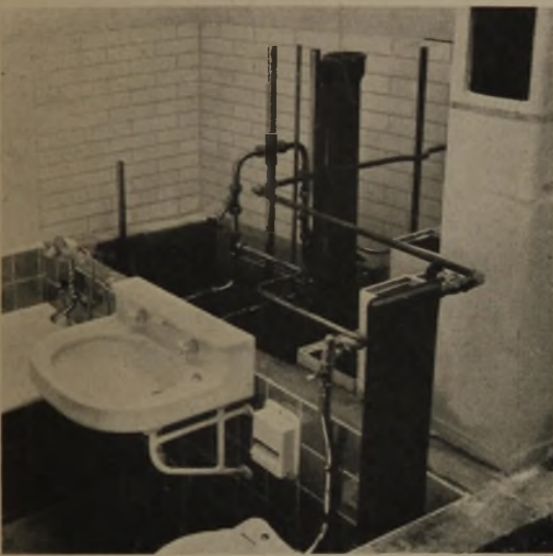
39 Ansicht des Installations-schachtes von Bild 38
