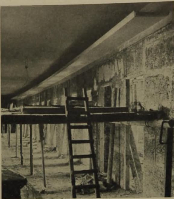
43 Tragkonstruktion für elektrische und Signal-Leitungen während der Ausführung (vgl. auch Bild 33) Aufnahmen von Dipl.-Ing. Santo aus dem Verwaltungsgebäude der I. G. Farbenindustrie, Frankfurt (Main)
