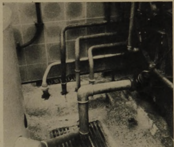
14 u. 15 Deckendurchführung von Rohren in einem nassen Raum (Waschküche)
