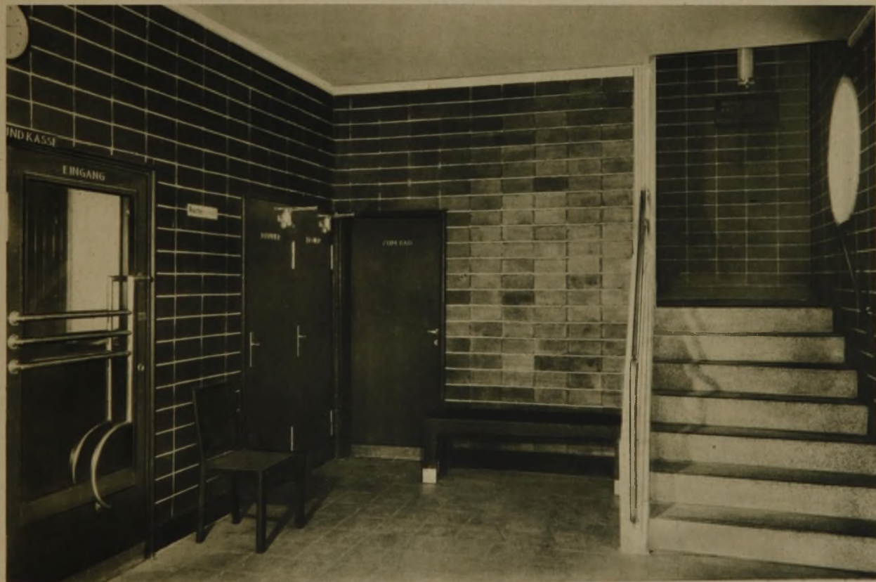
Vorhalle. Links Eingang zu den Schalterräumen, rechts Ausgang zum Arzt und zur Röntgenabteilung. Wandverkleidung aus schwarzbraunen Klinkerplatten, Decke matt-bläulich
