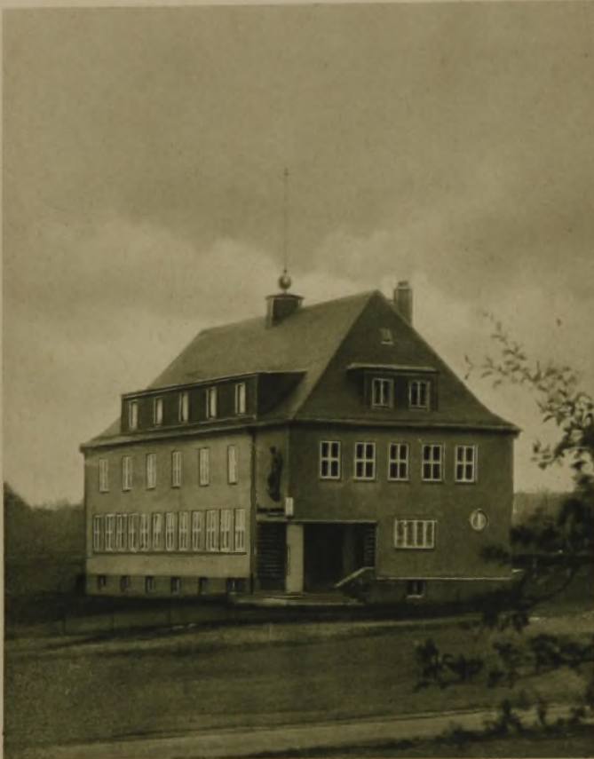
Ansicht. Material: Dunkle Schmelzklinker hell gefugt, hellgrüner rundverriebener Rieselputz, Thür. Schiefer, Hauptgesims und Fenstereinfassung weißlicher Vorsatzbeton, Fenster weiß mit dunkelgrauen Deckleisten
