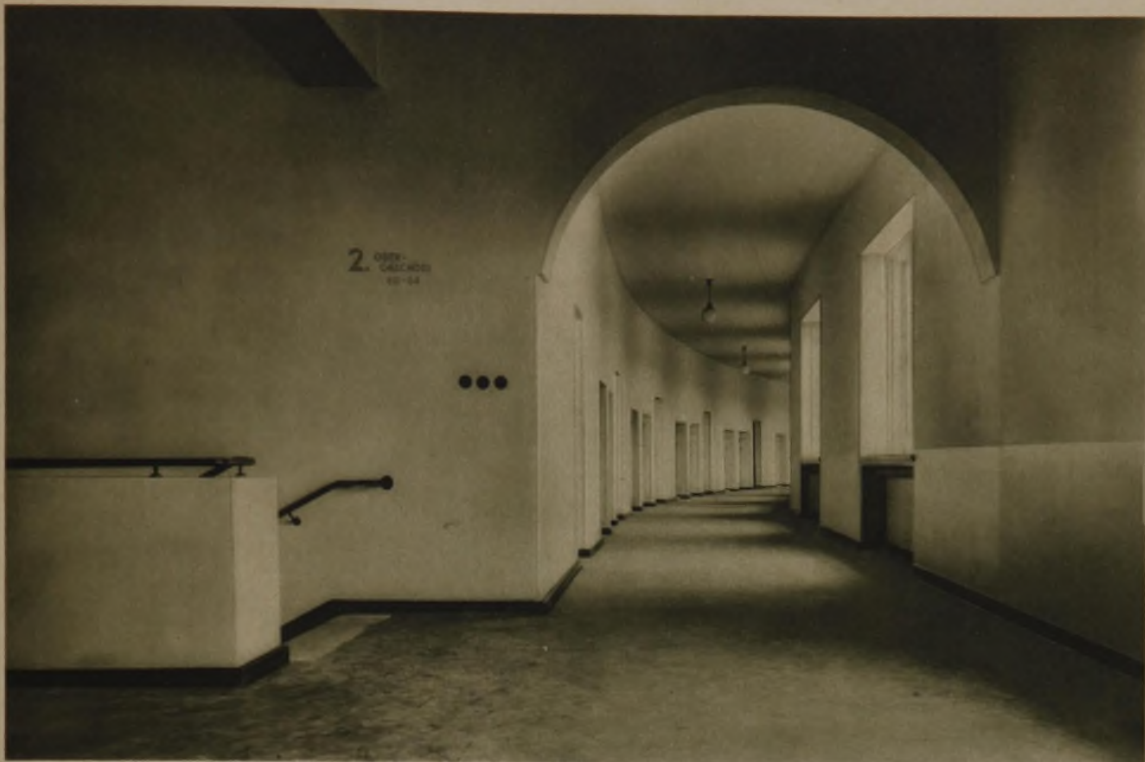
Flur mit Kleidernischen. Hell-lindgrüner bzw. mattgelblicher Anstrich, graues Linoleum, dunkle Sockelleisten. Die Eisenbetonunterzüge sind an ihren Unterseiten in den einzelnen Geschossen verschiedenfarbig abgesetzt.
