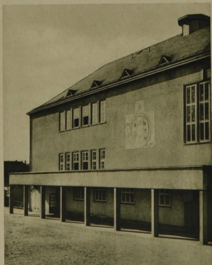
Ansicht vom Turn- und Schulsaalflügel am Turn- und Spielplatz mit überdecktem Wandelgang (auch Verbindung zur geplanten 2. Turnhalle)
