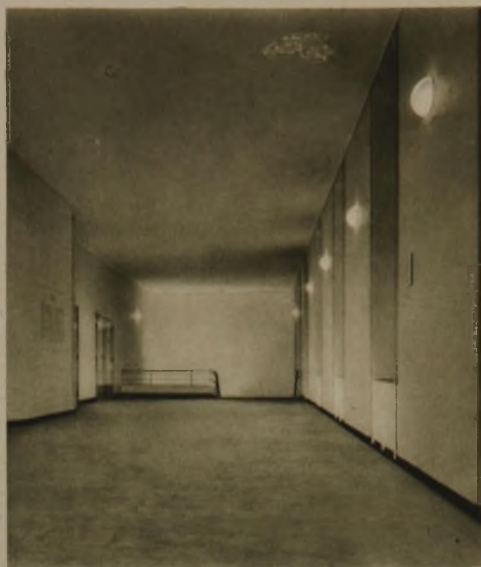
14 Hörsaalvorraum bei Beleuchtung. Muschelkalkfußboden. Wände in Wachsfarbenanstrich
