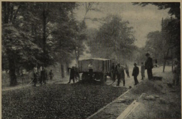
Aufbringen heißen Asphalt-Kleinschlags auf die Fahrbahn
