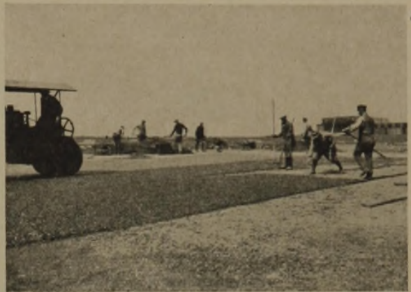
Aufbringen von Teersplitt und Müllschlacke
