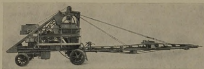
6 Mischer für Straßenbeton und Kaltasphalt Selbstfahrend mit schwenkbarem Bandausleger Hüttenwerk Sonthofen
