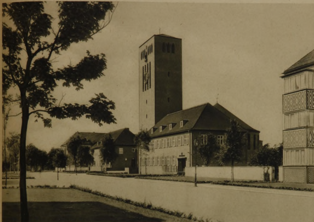
Ansicht vom Schuckertdamm. Backsteinrohbau aus gesandeten Normalklinkern
