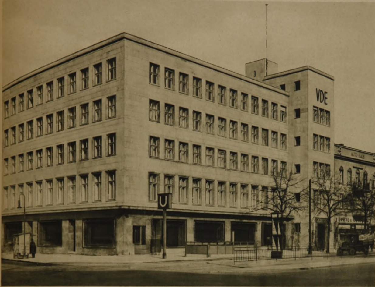
Straßenansicht. Fassaden Kirchheimer Muschelkalk, 3 cm starke Platten, hellfarbig und mit Sand geschliffen. Fensterumrahmungen, Blaubank, sauber geschliffen Fotos: Atelier Penz, Inh. W. Sahl, Charlottenburg
