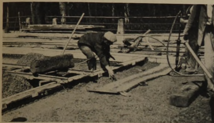
27 Prebluftstempelung von Betonstraße mit elastischer Zwischenlage C. Barasel A.-G., Stuttgart
