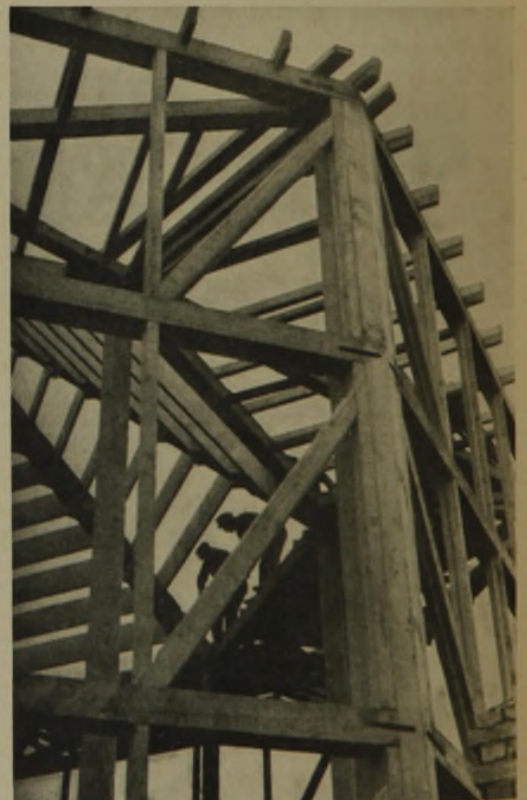
9 Ecksäulen. Blick in das Zeltdach
