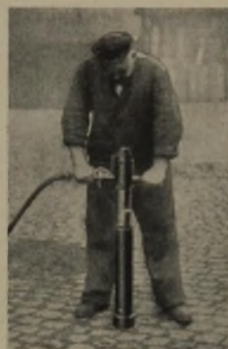
28 Prebluft-Pflastersteinramme Frankfurter Maschinenbau A.-G. FMA, Frankfurt a. M.
