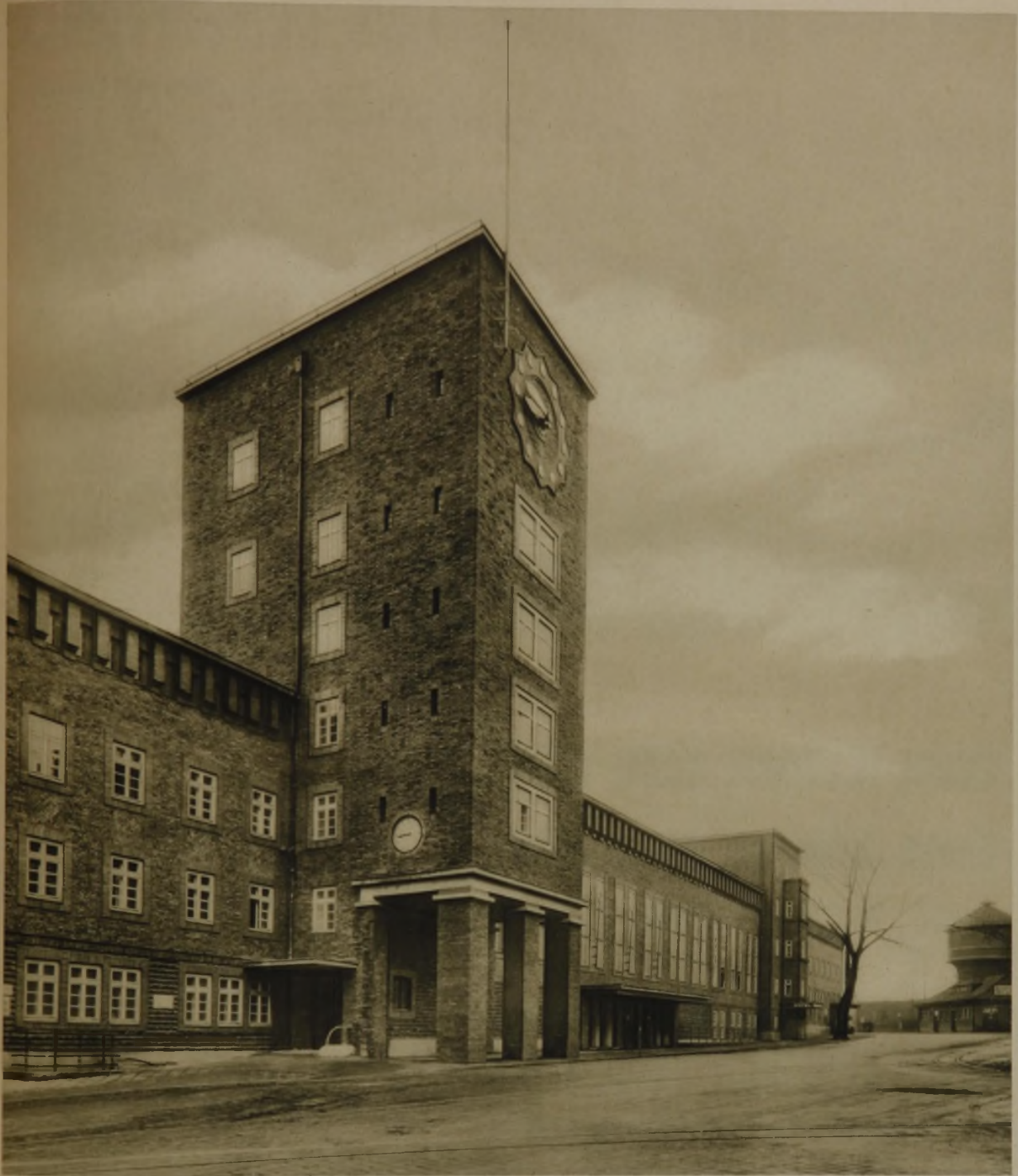
Grenzbahnhof Beuthen. Ansicht von der östlichen Seite des Vorplatzes
