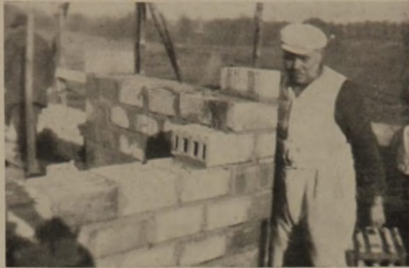
5 Eckmauerwerk in Frewenziegeln
