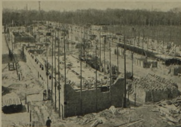
5 Die Baustelle der Zeilen 11 bis 14
