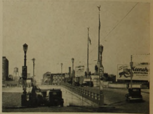
3 Unterführung und Überleitung des Verkehrs einer N-S-Straße
