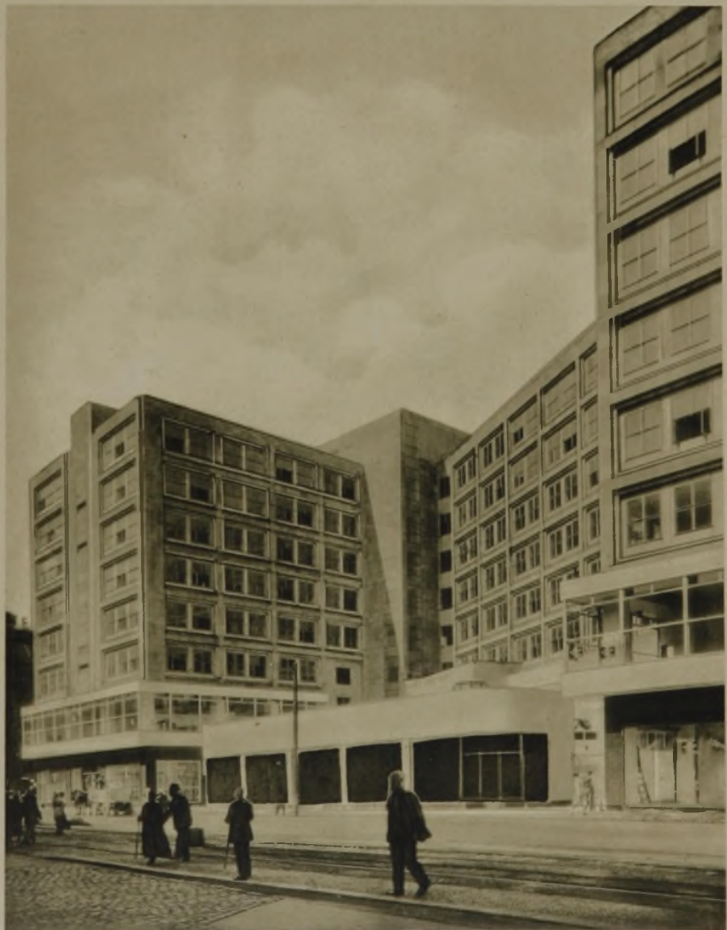
Ansicht des Hauses Alexander gegen Grünerstraße. In der Mitte der eingeschossige Flügelbau für Läden
