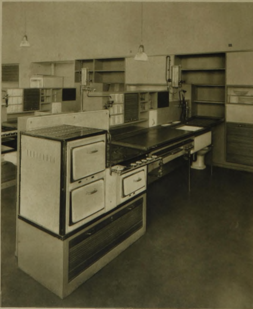
Eine Küchenboxe in der Lehrküche links Gasherd, darüber hochgelegener Wasserschwenkhahn; anschließend Arbeitstisch, darüber Gewürz- und Geräteschrank (mit Rolljalousie); unter dem Arbeitstisch Ausziehplatten zum Gemüseputzen und Handtuchhalter; anschließend Spültisch mit aufklappbarem Tropfbrett; unter dem Tropfbrett Ausgußbecken, über dem Spültisch elektrischer Heißwasserbereiter; rechts Regale, anschließend Geschirrschrank (oben) und Topfschrank (unten)
