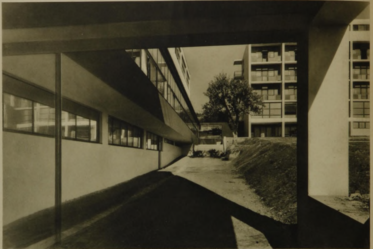
Durchblick nach NO. Links die Frauenberufsschule, rechts das zugehörige Wohnhaus. Der vorkragende Teil im ersten Geschoß der Berufsschule dient zur Erweiterung der dort gelegenen Klassenräume
