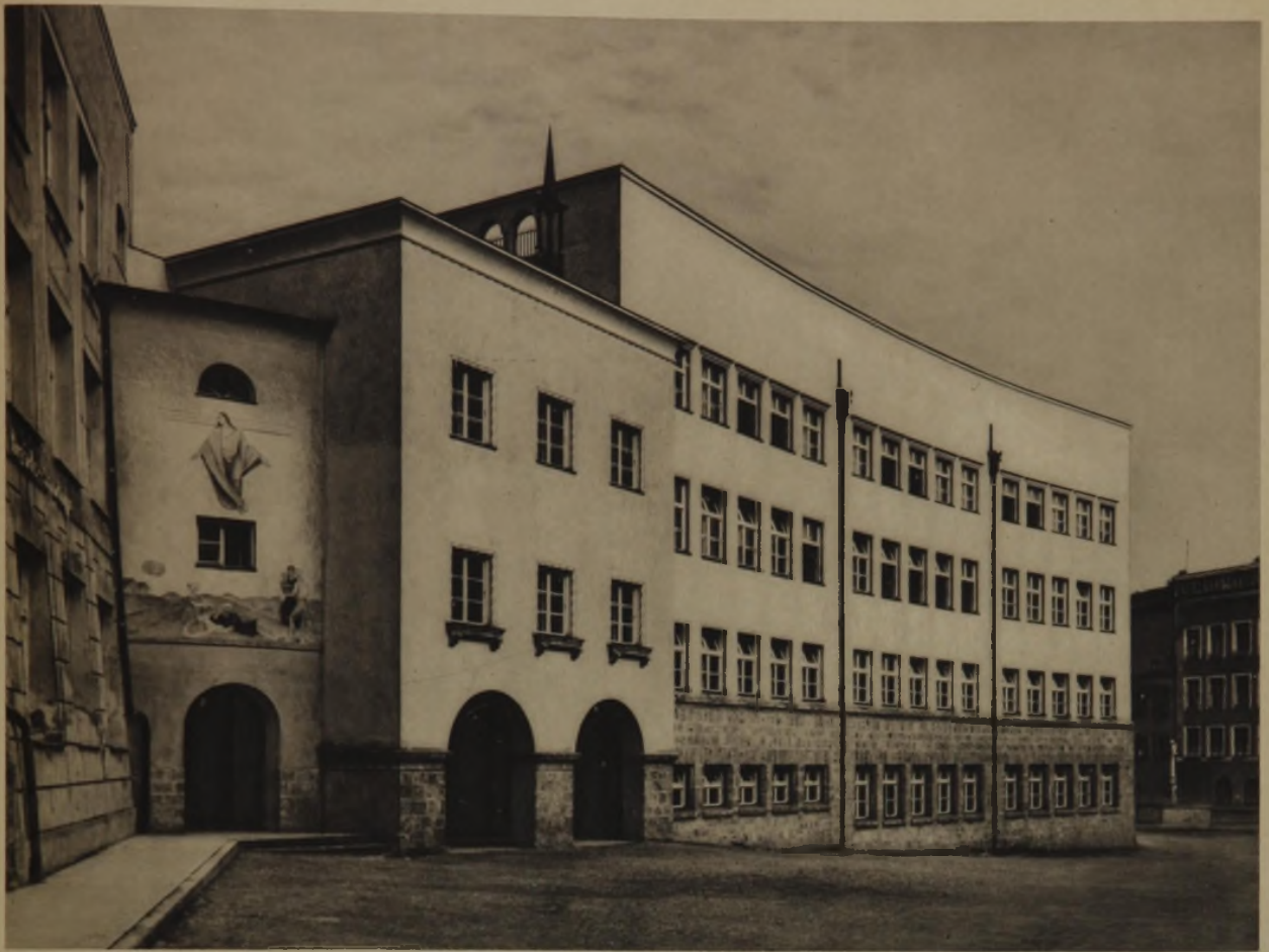
Ansicht am Stadtplatz. Die Fassade zeigt klar die dahinter liegende Raumteilung (je 3 Schulsäle in jedem Geschöß). Hinter der hohen Vorschußmauer die Turnzwecken dienende Dachterrasse. Links Übergangsbau zum alten Schulhaus, Wandbild in Keimfarben von Marianne Hertwig
