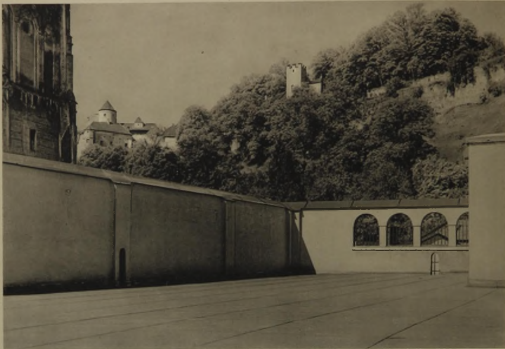
Dach-Terrasse der Schule für Turn- zwecke
