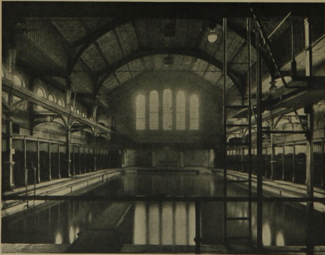
5 Schwimmhalle vor dem Umbau (Holzbau)
