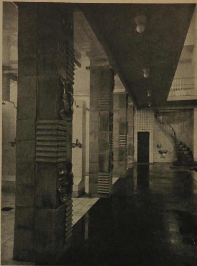
Mit Keramik verkleideter Pfeiler am Kopfende der Schwimmhalle
