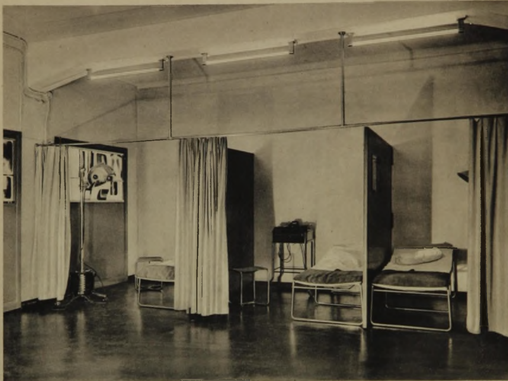
Höhensonnen- und Diathermie - Raum mit Kojen
