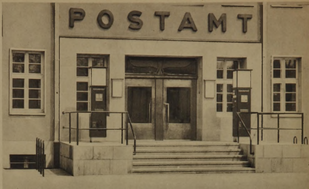
Eingangstür aus Kiefernholz mit Bronzeblech bekleidet. Im Oberlicht das Hoheitszeichen des Reiches, ein aus Bronzeblech getriebener Adler. Säulenbriefkasten postblau gestrichen
