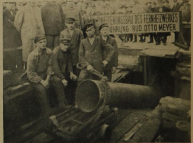
Abb. 3. Einbringung der Rohre unter der Straßenbahn.
