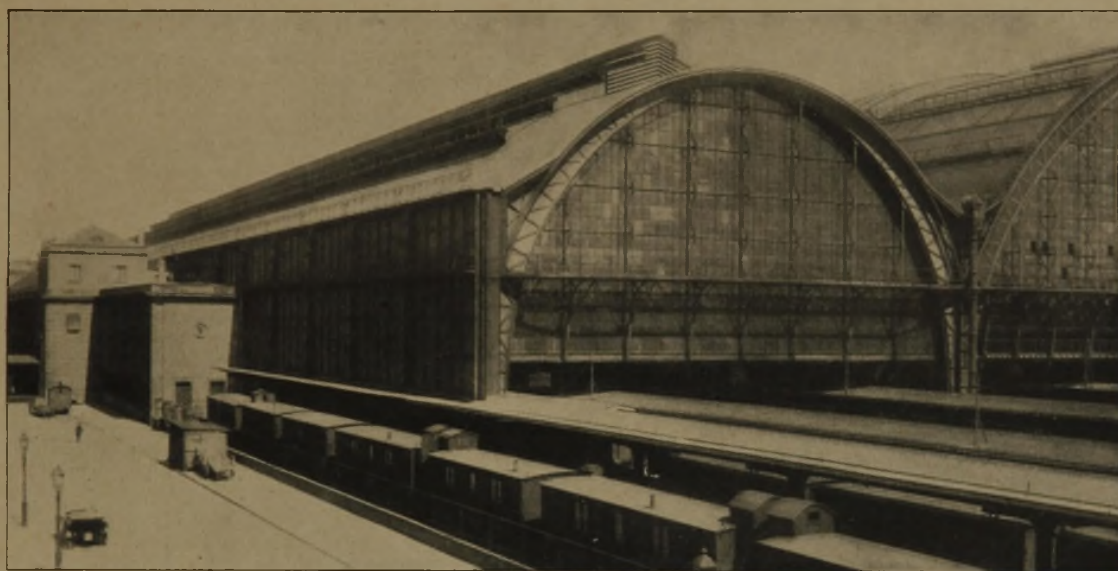
Abb. 8. Ansicht der Nordhalle von Westen gesehen.
