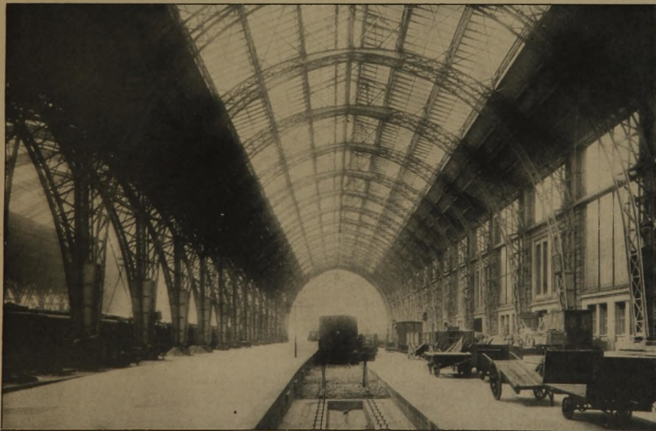
Abb. 1. Blick in die neue nördliche Halle vom Querbahnsteig aus.
