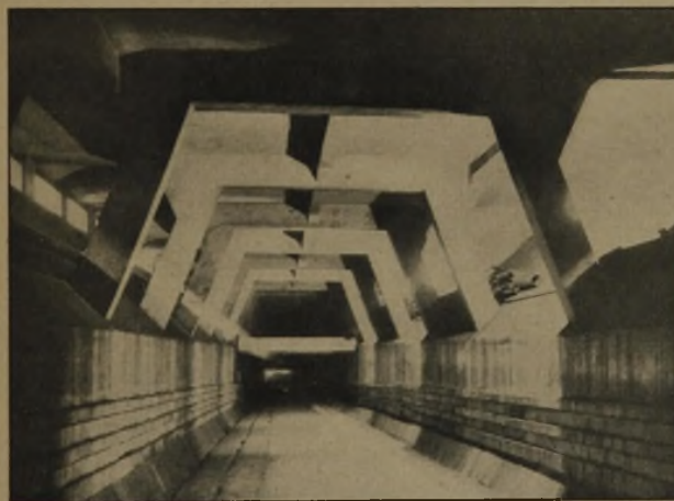
Abb. 21. Blick in den östlichen Teil des Längstunnels.
