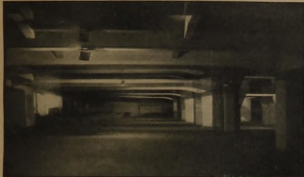
Abb. 19. Blick in Unterkellerung des Querbahnsteiges.
