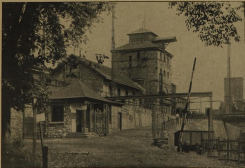
Abb. 32. Alter steinerner Förderschacht, Zeche Pörtingsiepen b. Essen. Industrie und Siedlung.
