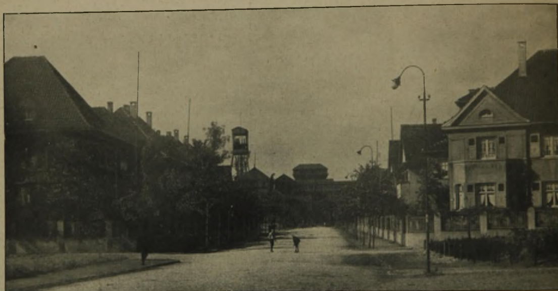
Abb. 25. Zeche Jacobi in Ostenfeld, arch.-städtebaul. einwandfreier Aufbau.
