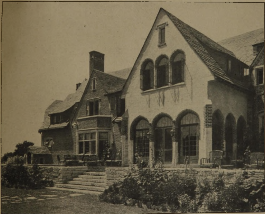
Abb. 34. Herrenhaus beim Dorf Kohler. Haupteingang. Arch. Brust & Philipp, Milwaukee. Ansichten aus dem Dorf Kohler bei Milwaukee.
