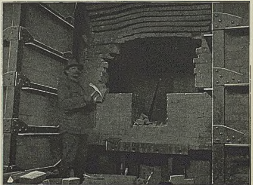
Abbildung 9. 40-t-Martinofen mit abgenommener Gaszuführung bei Erneuerung der Stirnwand nach 282 Chargen.
