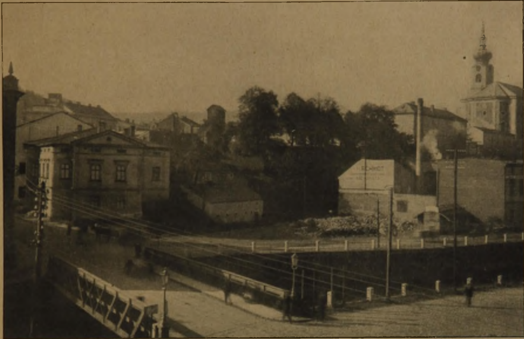
Abb. 10. Jetziger Zustand der Umgebung des Brückenplatzes.
