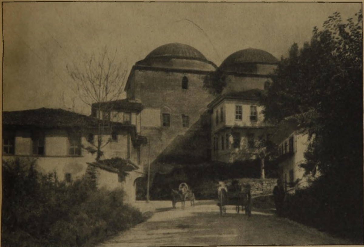
Abb. 7. Yeni Kaplıcscha. (Neues Thermalbad.)
