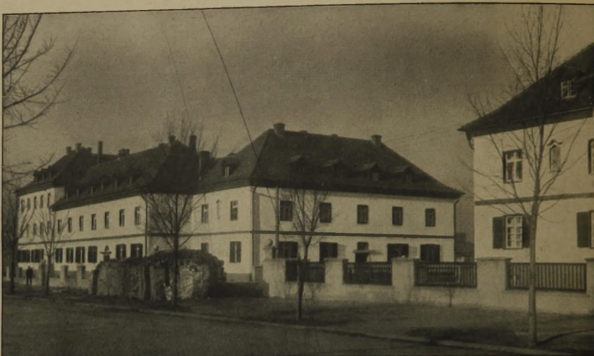
Abb. 18. Hausgruppe an der Gneisenaustraße der Siedlung Gleiwitz.
