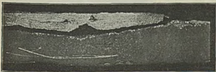
Abbildung 12a. Vergrößerter Querschnitt durch ein graphitisch zerstörtes Rohr.
