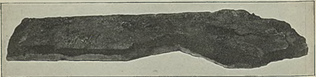
Abbildung 12. Stück eines durch vagabundierende Ströme graphitisch umgewandelten und zerstörten 400-mm-Gußrohres.
