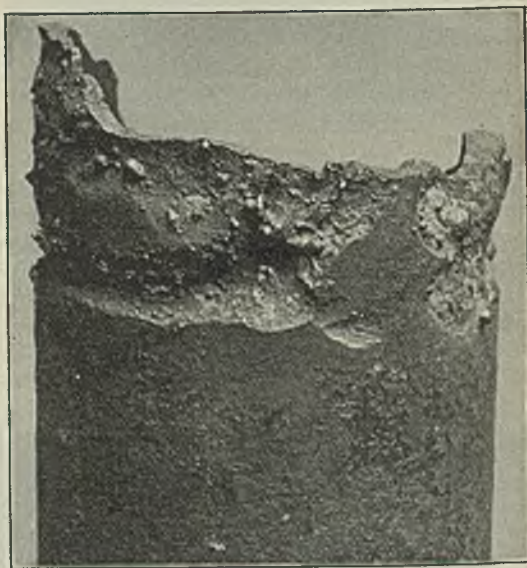
Abbildung 17. Durch Kurzschluß geschmolzenes Gußrohr.
