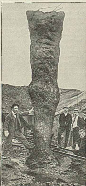
Abbildung 7. Ein ausgegrabener Pfahl.
