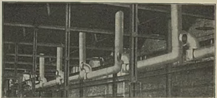
Abbildung 8. Lüftungs- und Kühlungsanlage in Einzelanordnung.
