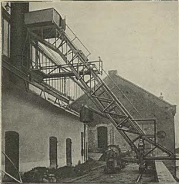
Abbildung 2. Fahrbarer, elektrisch betriebener Schrägaufzug. Förderkübel in Mittelstellung.
