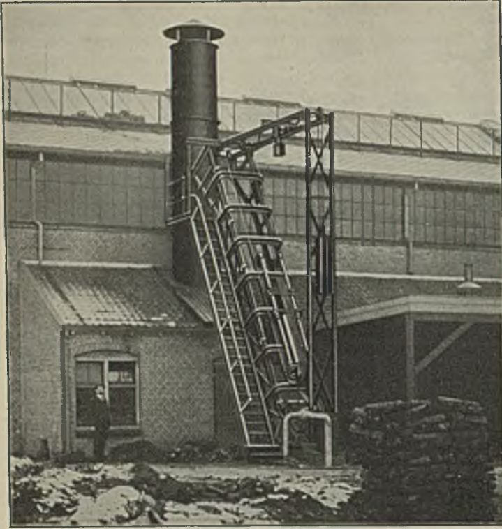
Abbildung 7. Feststehender, mit Wasserdruck betriebener Schrägaufzug.
