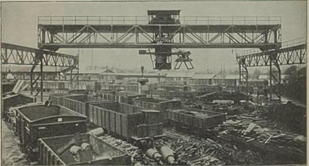
Abbildung 1. Magnet- und Muldentransportkran.
