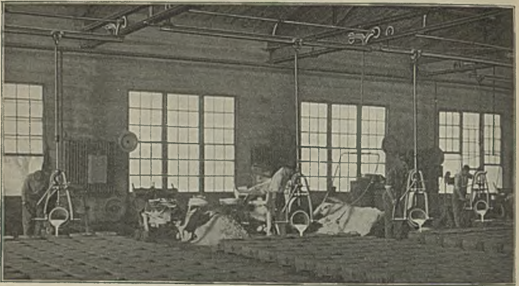
Abbildung 2. Abgießen von Formen mit Hilfe von Handlaufkränen.
