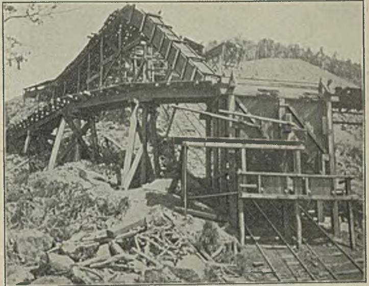
Abbildung 4. El-Cuero-Grube. Hölzerner Erzbehälter über dem Bremsberg.
