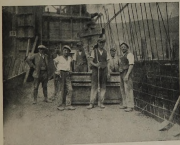
ABB. 4. AUF DER KERNDAMMER. Rechts Bewehrung
