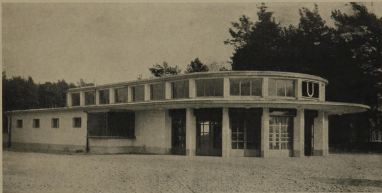
BAHNHOF KRUMME LANKE, EMPFANGSGEBÄUDE
