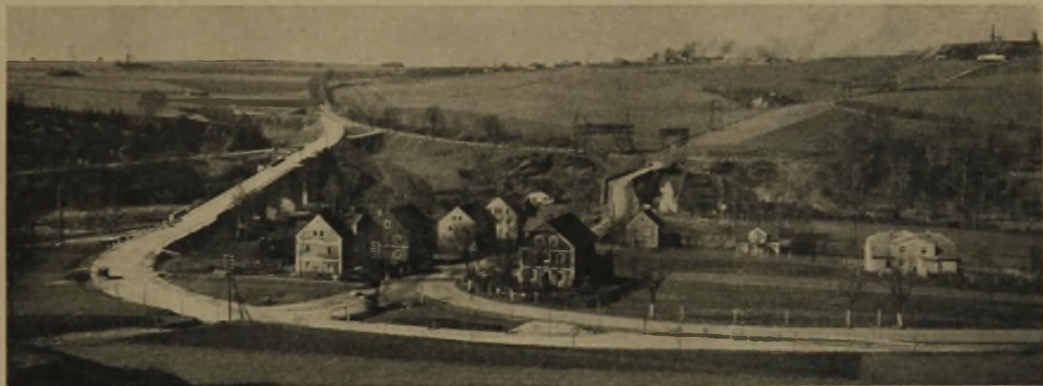
Staatsstraßen-Verlegung mit Talbrücke in Hasselbach bei Freiberg i. Sa.
