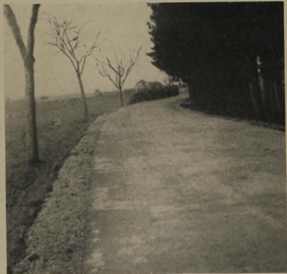
Bez.-Straße Lenting—Kösching, Bez. Ingolstadt Zementschotterdecke. 7 cm Schotter, 7 cm Mörtel, darauf dünne Lage Schotter, dann eingewalzt
