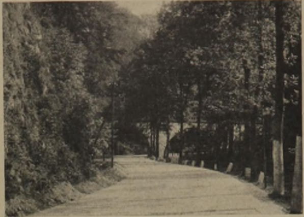
Hönnetalstraße Landkreis Arnberg Einschichtige Betondecke von 12—13 cm auf alter Chaussierung, Querfugen alle 15 m
