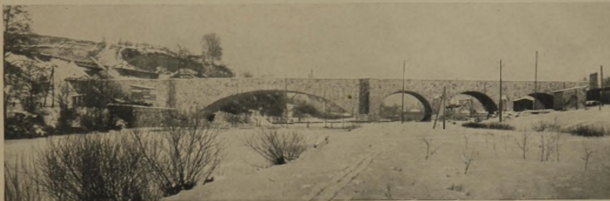
Mulde-Brücke im Zuge der Fernverkehrsstraße bei Penig i. Sa. (vgl. Abb. 2 vorn)
