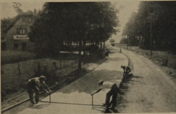
Staatsstraße Nürnberg—Feucht Je nach Untergrund ein- oder zweischichtig. Mittlere Längsfuge, daher Freihaltung einer Verkehrsspur im Bau. Vorn Herrichtung der Querfugen
