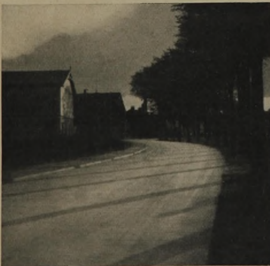
Deichstraße in Uetersen, Holstein Zweischichtige Betondecke statt alten Pflasters auf 10 cm starker Kiesbettung. Querfugen in 8 m Abstand
