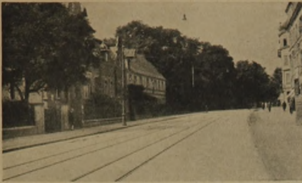
Warendorfer Straße in Münster i. W. Zweischichtige Betondecke, Straßenbahnschienen auf Beton-Längsschwellen
