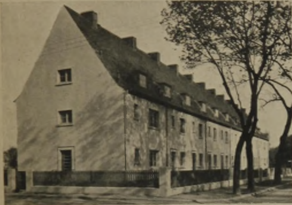
Wohnhaus der Gagfah
