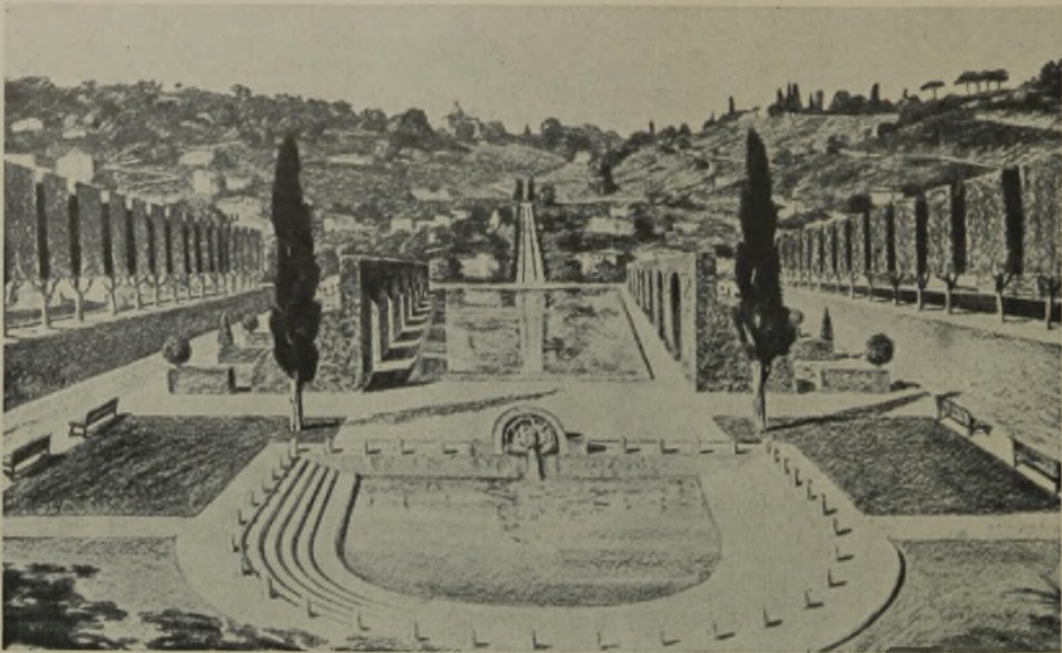
Abschluß der Mazzini-Straße am Monte Mario
