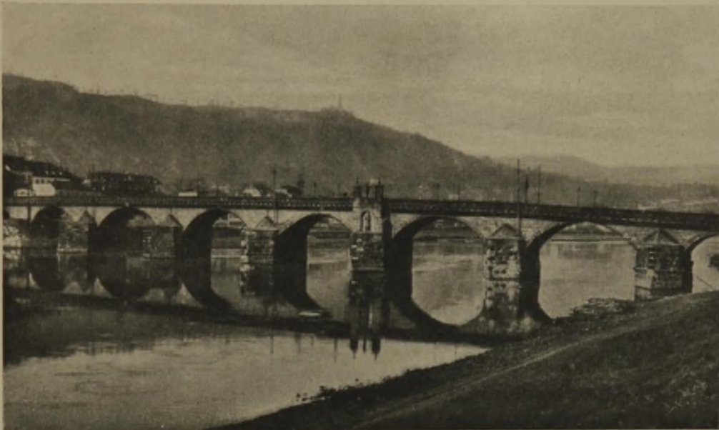
Alter Zustand vor dem jetzigen Umbau
