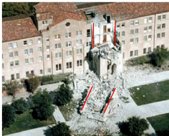
Rys. 2.6. Zniszczenie wynikające z nieregularnego rzutu, za [22].
