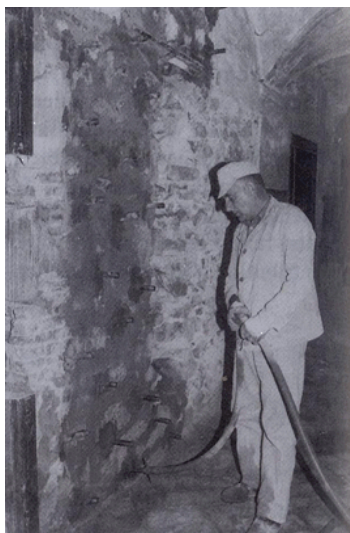
Rys. 2.15. Wzmacnianie muru iniekcją zaczynu, za [125].
