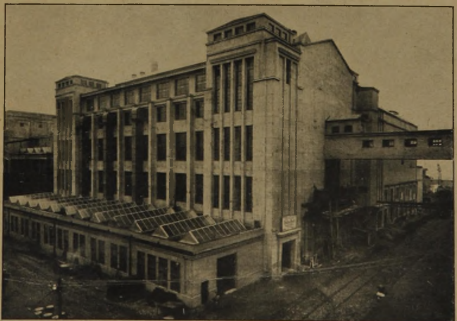
Abb. 1. Affinationsgebäude mit vorgelagerter Rohzuckerhalle und Verbindungssteg zur Würfelzucker-Fabrik.
