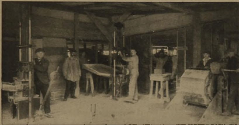
Abb. 6 (darunter). Maschinen zur Herstellung der Hohlsteine.
