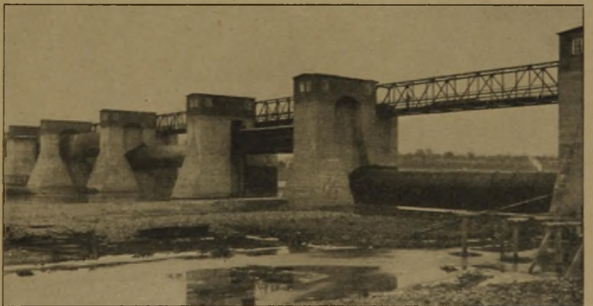
Abb. 5. Staustufe Wieblingen. Teilansicht des Walzenwehres
