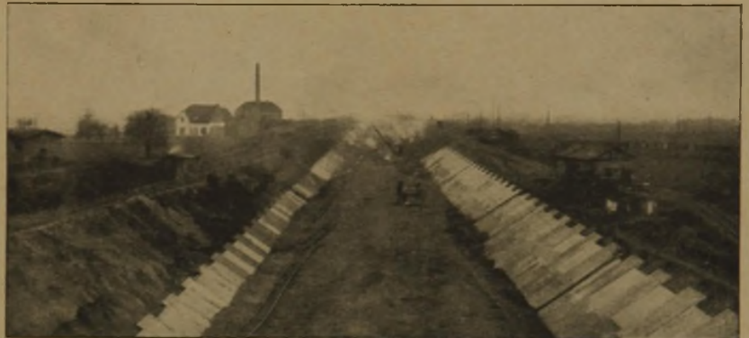
Abb. 4. Staustufe Ladenburg. Oberkanal im Bau. Betonbekleidung der Böschungen.
