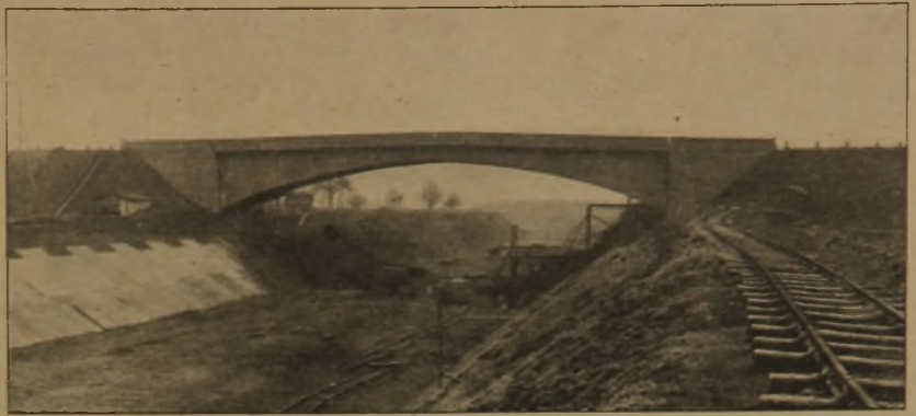
Abb. 3. Staustufe Ladenburg. Betonbrücke über den Oberkanal.
