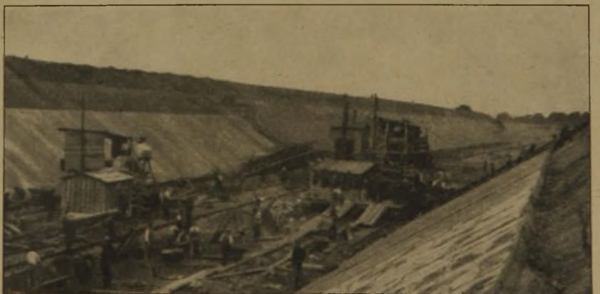
Abb. 6. Staustufe Wieblingen. Maschinelle Herstellung der Betondeckung der Kanalböschungen
