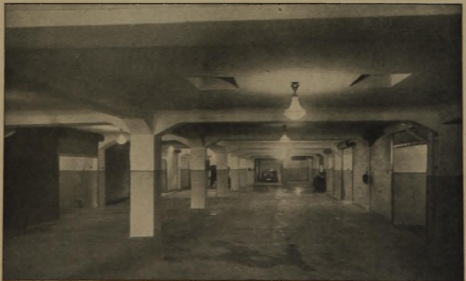
Abb. 8. Blick in ein Untergeschoß der Garage.
