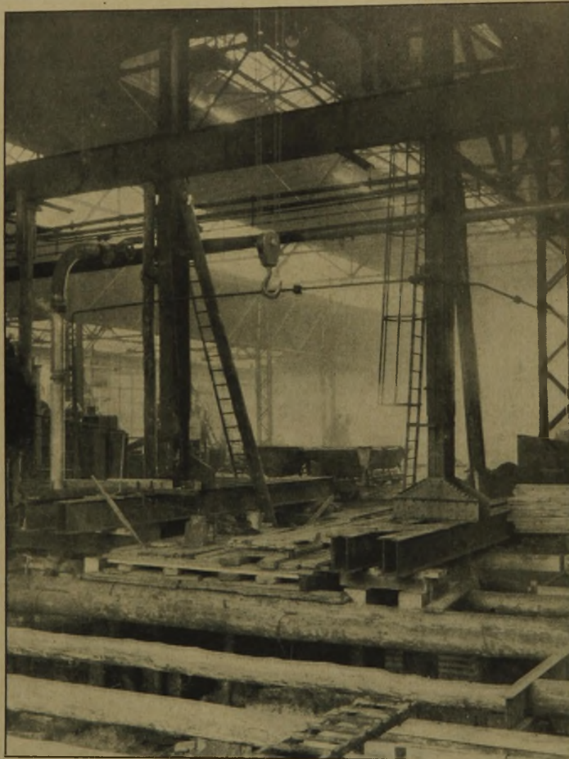
Abb. 5. Tiefgründung eines Maschinenfundaments. Abfang einer Hallenstütze mittels provisorischen Fußes und Pfahljoches.
