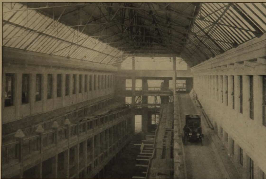
Abb. 1. Blick in eine der beiden Garagenhallen kurz vor Fertigstellung.
