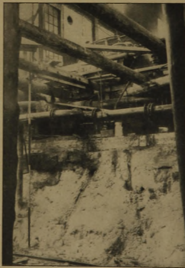
Abb. 8. Baugrube in Nähe des Fundaments der im Betriebe befindlichen, angrenzenden Maschine. Der trockengelegte Boden böschet sich frei nach der Baugrube hin.
