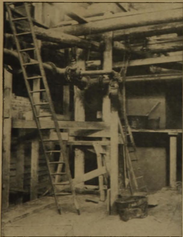
Abb. 7. Baugrube bis 5 m unter Grundwasser ausgehoben. In Bildmitte ein Brunnen der Absenkungsanlage sowie 2 Rammfähle für Abfangung der Hallenstützen.
