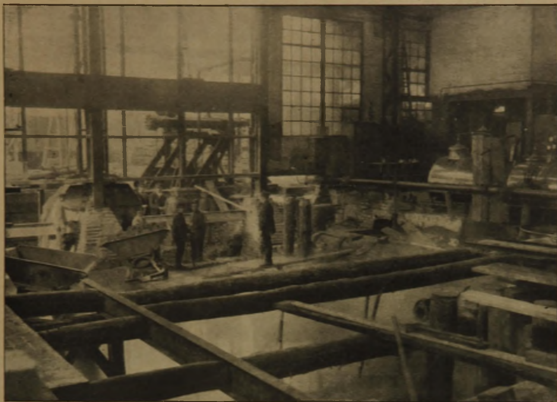
Abb. 6. Baugrubenaushub bis auf Grundwasserhöhe vor Einbau der Wasserhaltung. Rechts die Zylinder der zu unterfangenden Maschine, links zwei der über der Baugrube abzufangenden Hallenstützen.
