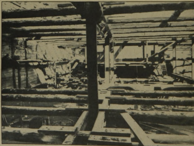
Abb. 2. Blick in die aufgeschlossene Baugrube. Längs der Bohlwände Saugleitung der ersten Staffel.
