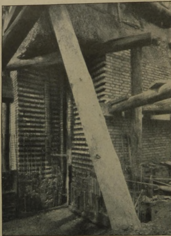
Abb. 1. Unterfangung einer angrenzenden Gebäude-Ecke, Ausschachtung bis 4,8 m unter Grundwasserspiegel.
