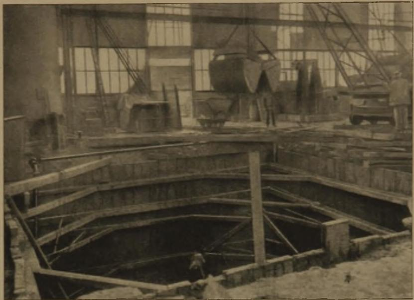
Abb. 6. Blick in die ausgesteifte Baugrube. (Urspr. Ausführung)
