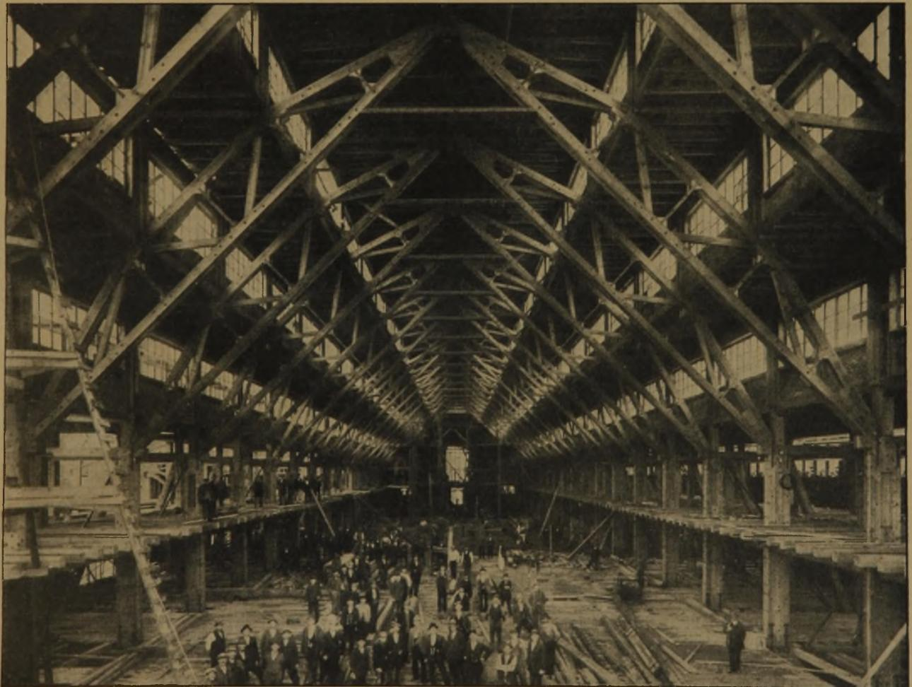
Abb. 1. Blick in die Radiohalle vor Verkleidung der Fachwerkbinder.
