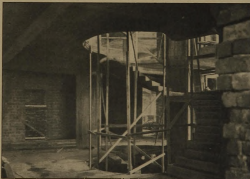
Abb. 5. Blick in das Treppenhaus während des Treppenbaues.
