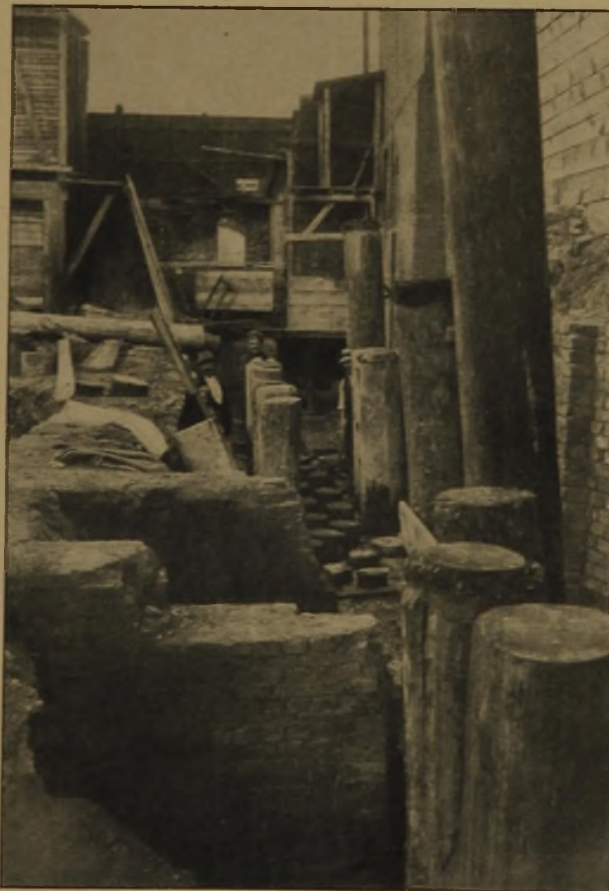
Abb. 7. Pfahlrammung zwischen alten Fundamentresten.
