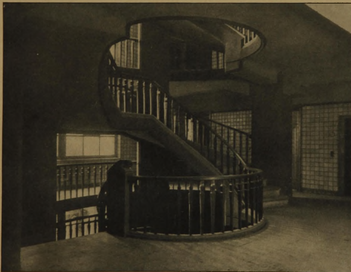
Abb. 1. Blick in das Haupttreppenhaus mit fertiger Treppe.
