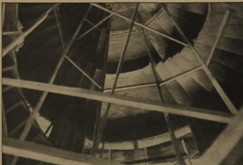
Abb. 4. Blick von unten in die Haupttreppe während der Ausführung.
