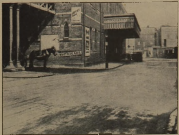
Abb. 4. Betonstraßen im Vordergrund mit Teer, hinten mit Wasserglas behandelt.
