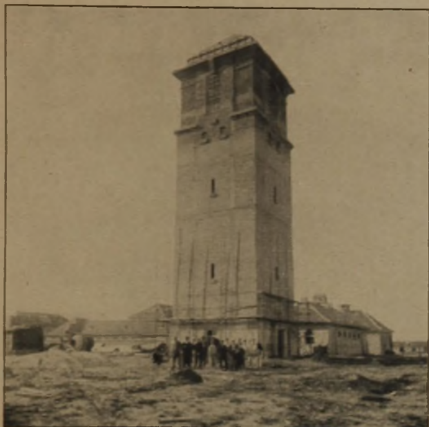
Abb. 8. Fertiger Turmkörper vor dem Verputzen mit einem Teil des Putzgerüsts.
