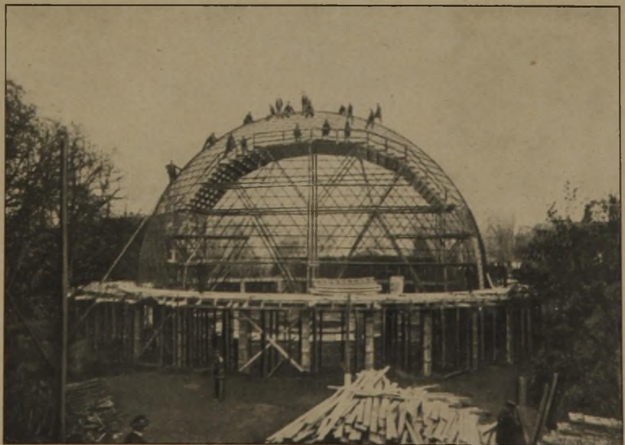
Abb. 1. Ausführung der 25 m weit gespannten Kuppel des städt. Planetariums in Jena.
