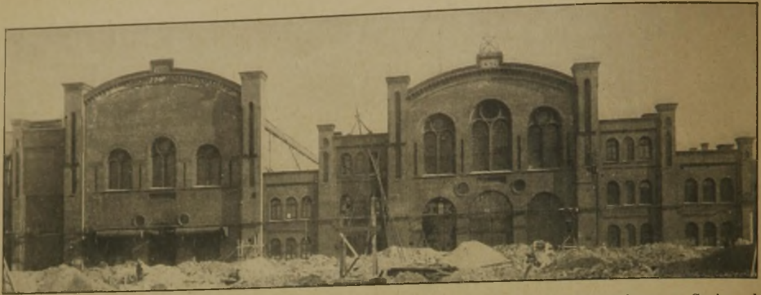
Abb. 9. Alte Backsteinfassade der Montagehalle nach Niederlegung älterer Gebäude.
