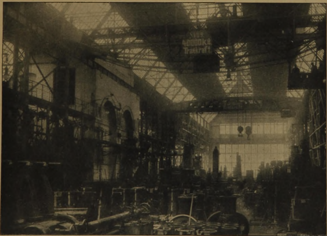
Abb. 14. Blick in die Halle vor Abbruch der massiven Fronten.
