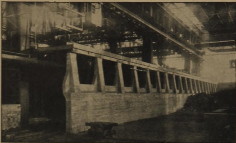
Abb. 2. Eisenbeton-Schrottplatz-Abschluß im neuen Stahlwerk des Bochumer Vereins. (Vgl. Abb. 4, S. 132.)
