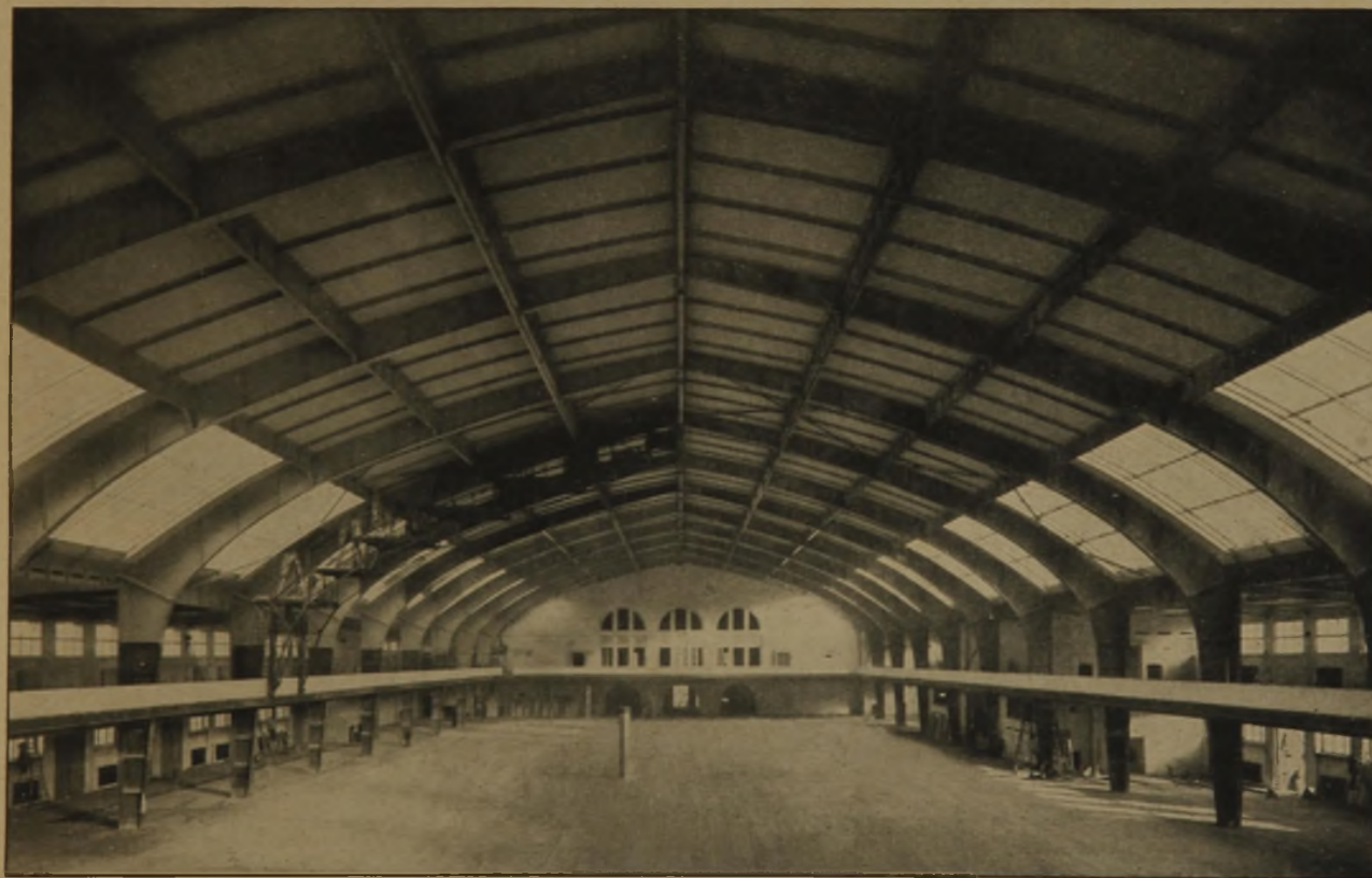
Abb. 5. Blick in die fertige Halle gegen den Nordkopf. (Links das Revisions-Gerüst.)
