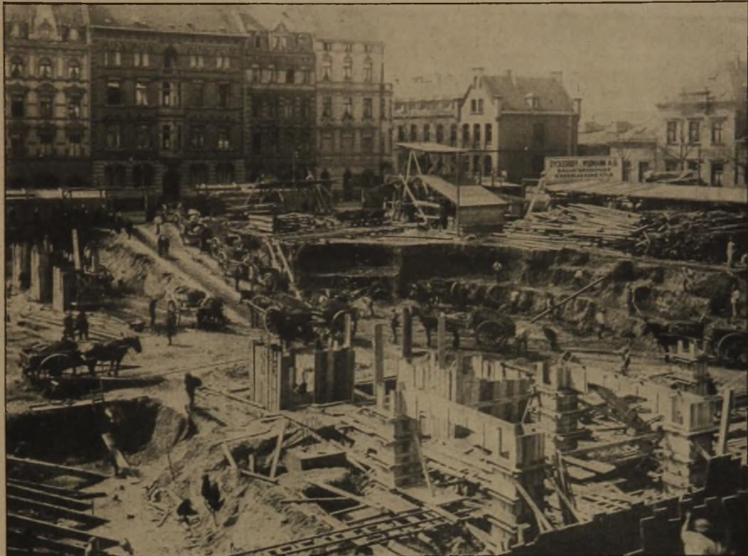
Abb. 7. Blick in die Baustelle. Ausschachtungsarbeiten, Einschalung der Säulen (26. 4. 24).
