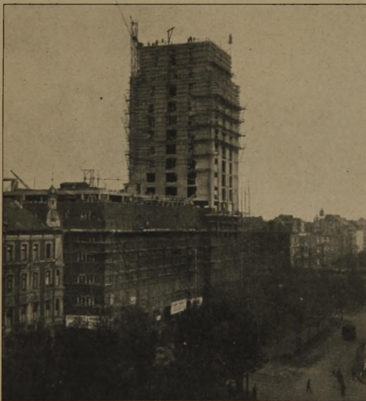
Abb. 8. Aufbau des Turmhauses in der Schalung.
