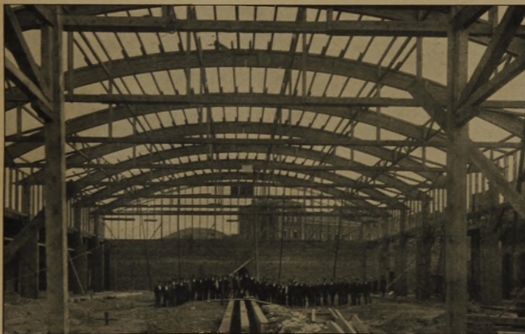
Abb. 1. Messehalle im Bau. (Hauptbinder aufgestellt.)
