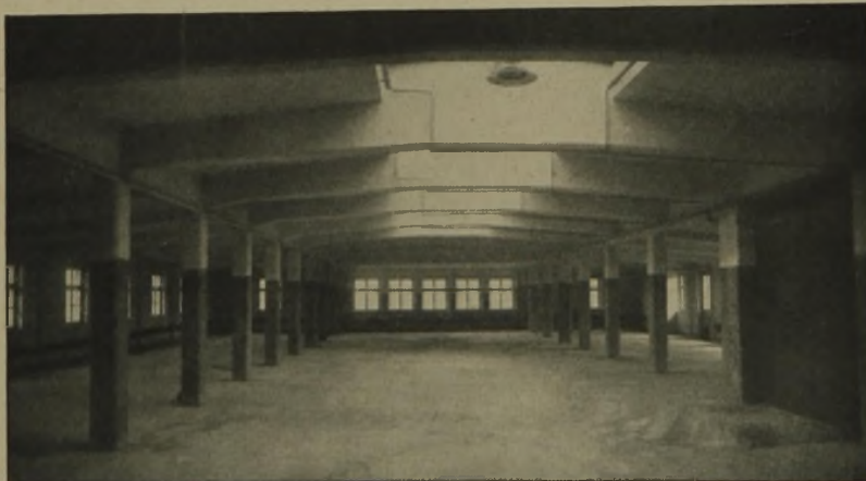
Abb. 2. Blick in das Oberste Geschoß des Garagenbaues.
